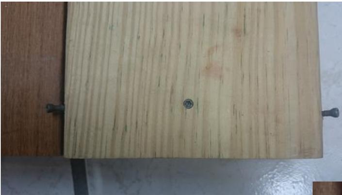
Instalación correcta para anchos de 110mm hasta 140mm
